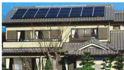
3.67Kwシステム
